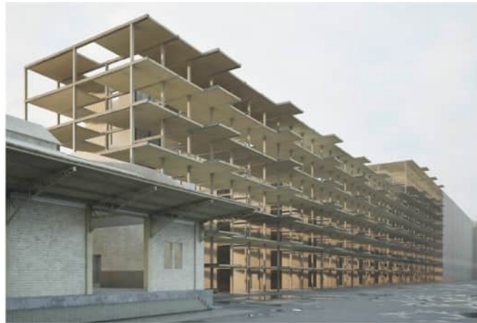
Struktur in Hybridbauweise - Betonstützen - Hybridbeam - Brettschichtholzplatte
