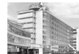
Brinkman & Van der Vlugt, Van Nelle Fabrik, Rotterdam, 1925-31
