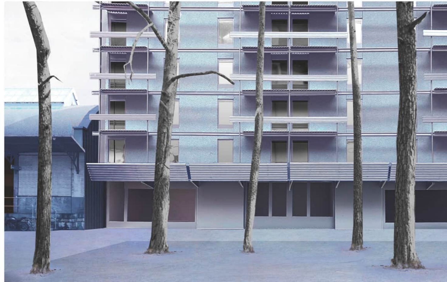
Zirkulär, kontextuell und identitätsstiftend: Die vorgehängte Balkon- und Pflanzschicht ist vollständig aus Re-Use-Materialien gefügt, die zu einem leichten Filter zwischen Hof und Haus werden
