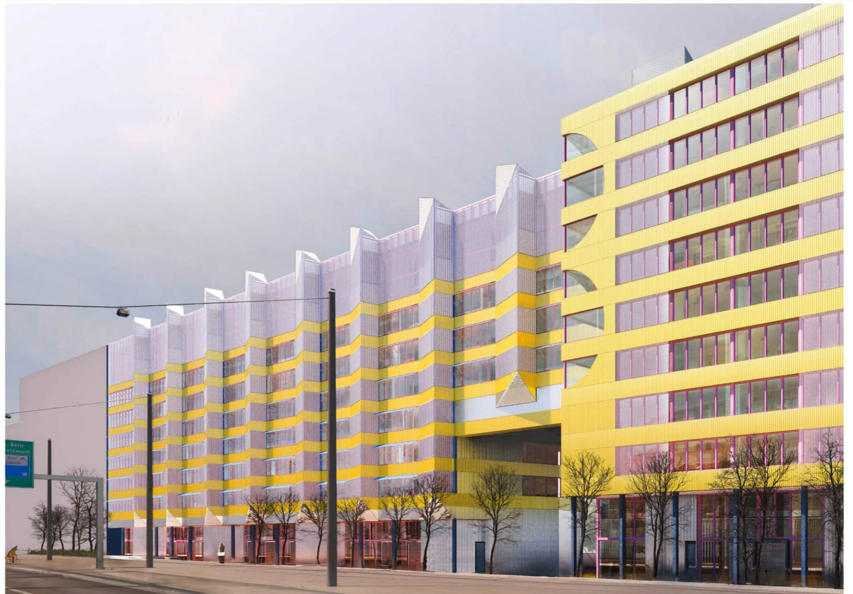
Die leichten einlagigen Windflügel prägen die neue Typologie. Als Windhöfe versorgen sie die Wohnungen mit frischer Luft. Mit moderateren Parametern zum Störfall lassen sich die Windhöfe durch Einbau von Decken zu gestapelten Wintergärten mit öffentlicher Fassade transformieren.
